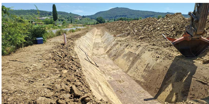
Proseguono i lavori per la realizzazione dello scolmatore sul borro Rabatta
