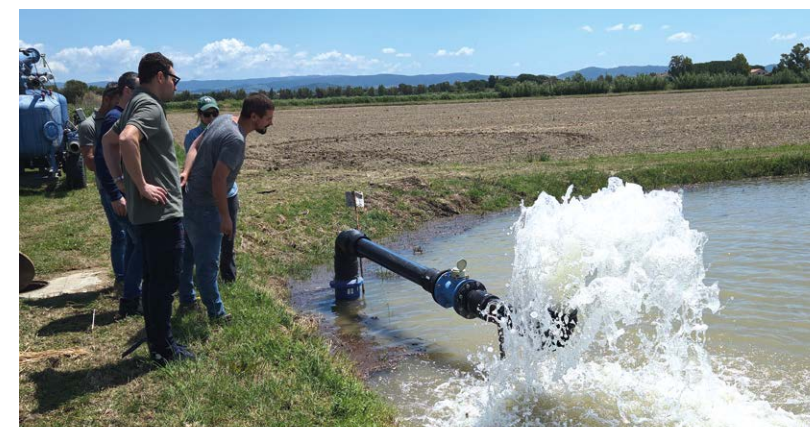
L'apertura di un idrante per l'irrigazione di una risaia
