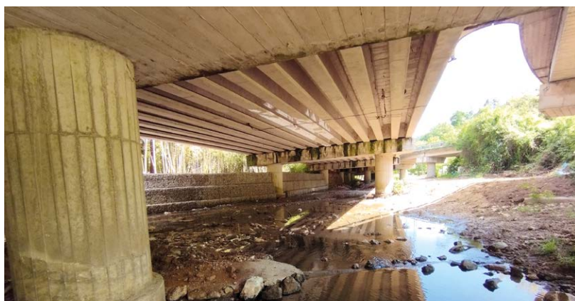
La gabbionata realizzata sotto lo svincolo di Siena Ovest
