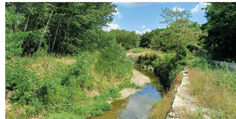
La scogliera realizzata per proteggere il ponte della strada di Sant'Antonio
