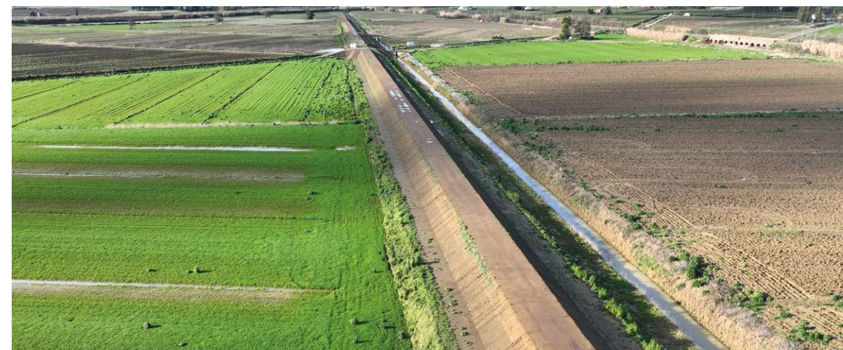
Il nuovo argine costruito a completamento della futura cassa di espansione in località Beccarello
