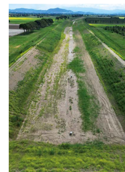
La costruzione dell'invaso sul canale Diversivo in località Cernaia
