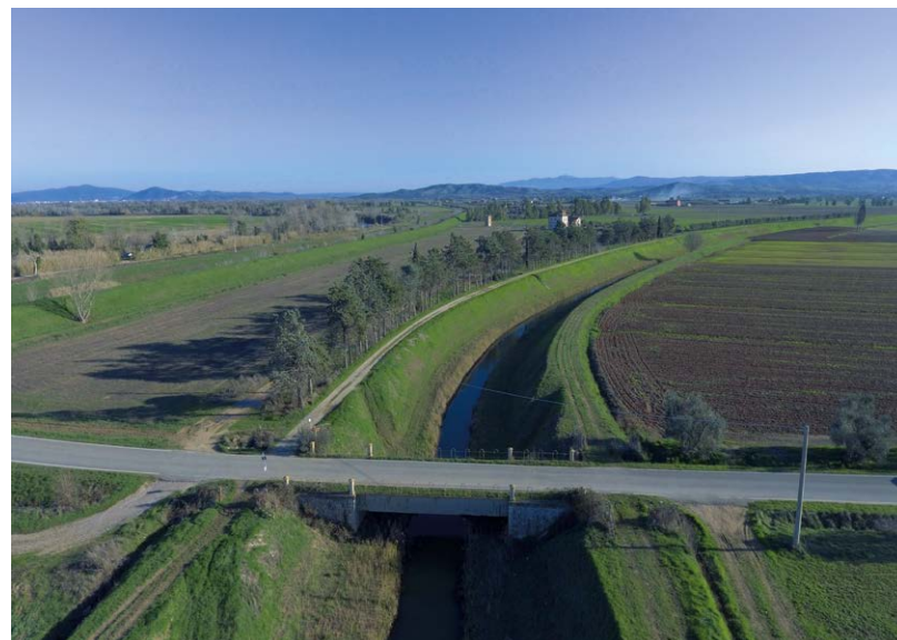
Il punto subito a monte del ponte sul canale Essiccatore principale su cui sarà posizionata la diga mobile
