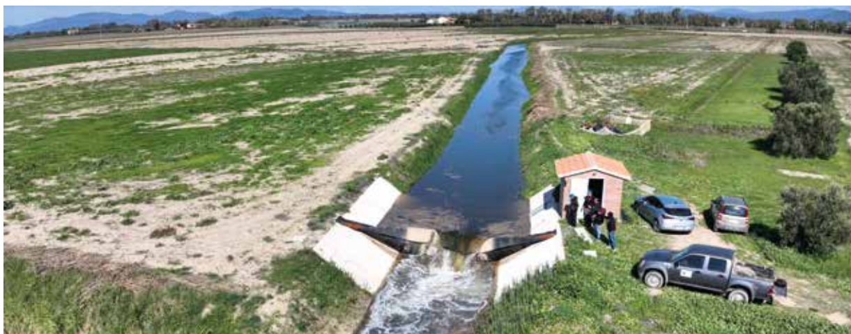
Lo sbarramento mobile in gomma è un impianto innovativo a sostegno di un'agricoltura di qualità
